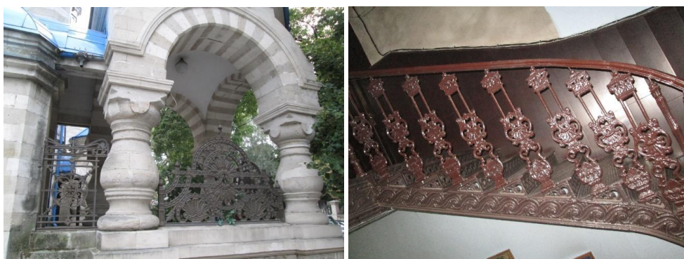
Biserica Sf. Cuv. Teodora de la Sihla. Împrejmuirea de fontă din exterior și scările de fontă din interiorul bisericii. Foto Liliana Condraticova
