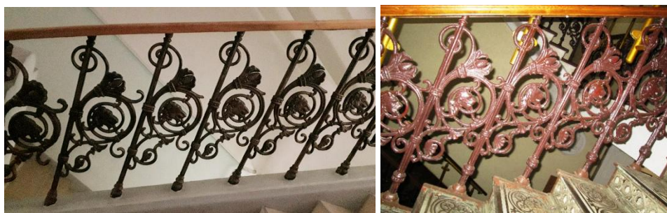
Baluștri de fontă, scara Blocului de Artă, Biblioteca Națională a Republicii Moldova; Scara blocului administrativ al Universității Tehnice din Moldova. Foto Liliana Condraticova
